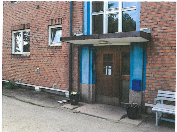
Eksempel på etterisolering med utvendig isolasjon og murt forblending. Foto: SINTEF Byggforsk
